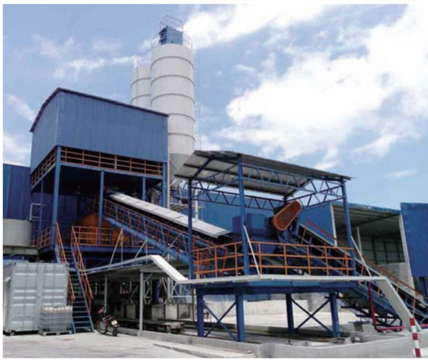
基樁投料 Pouring concrete of P.C. piles
